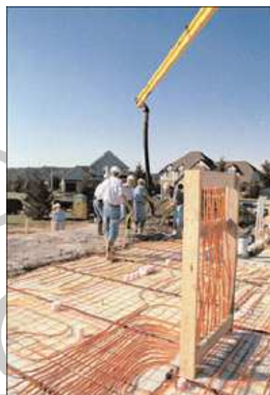
Figura 1. Manguera PEX para Calefacción tendida en un patrón Específico antes del colado del Firme.
